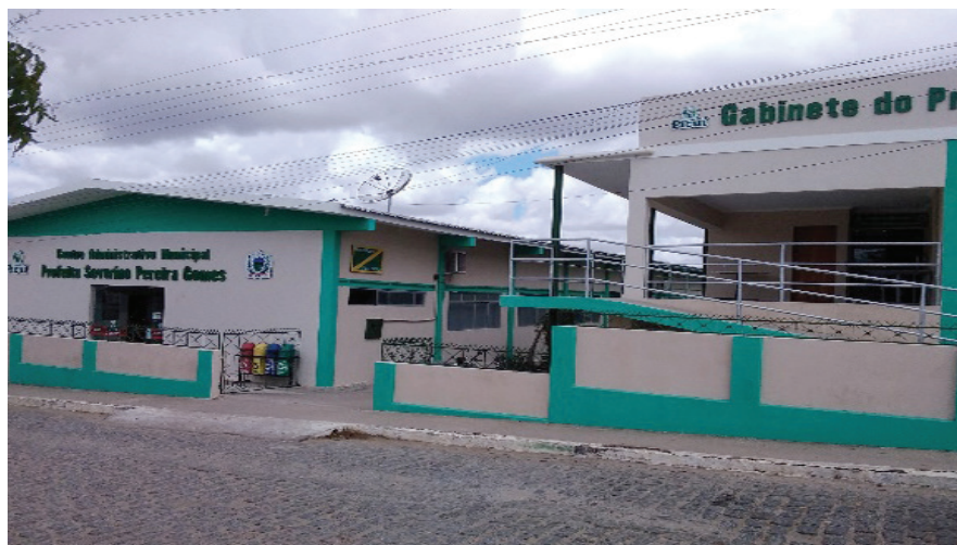
Centro Administrativo Municipal de Picuí/PB
